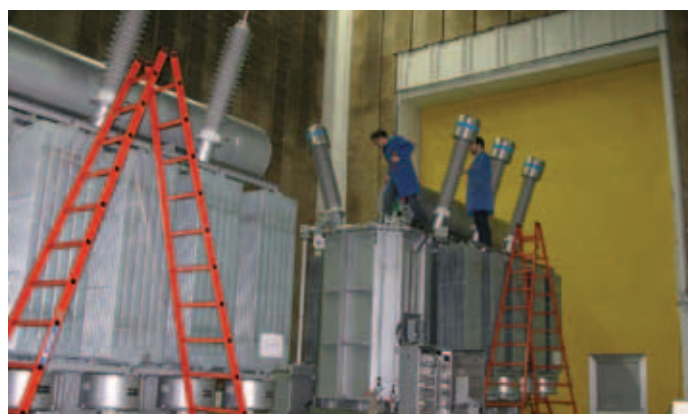
Priprave na končno preizkušanje transformatorja, kjer jih naročniki tudi prevzamejo. V tako imenovani brezšumni sobi, ki spominja na Nasin center, pred prevzemom v transformator udari še umetno ustvarjena strela. Če ji transformator kljubuje, je z njim za 50 let mir, toliko je namreč njegova življenska doba. V nasprotnem morajo v Etri 33 izdelati novega.
